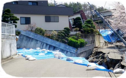
東日本大震災での擁壁の倒壊事例
